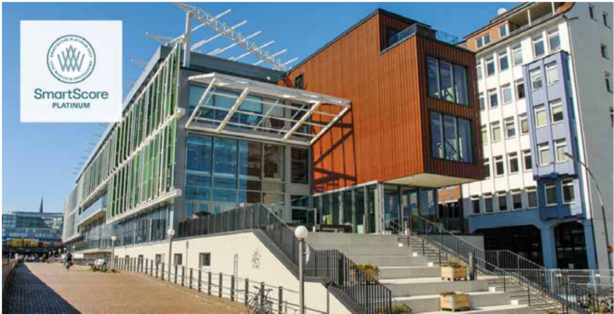
Hammerbrooklyn.DigitalPavillon: Erstes zertifizierte Smart Building in Deutschland (SmartScore in der höchsten Auszeichnungsstufe Platinum)
