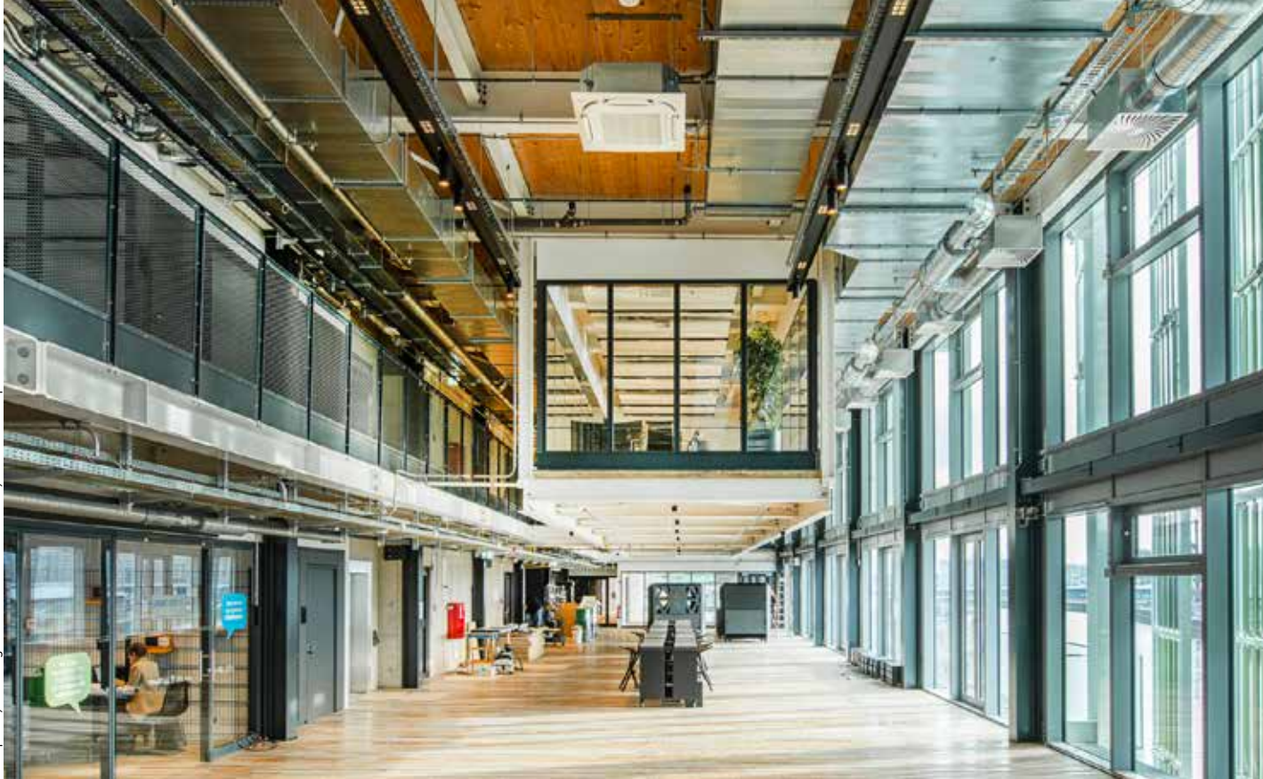
Hammerbrooklyn.DigitalPavillon: Benchmark für Smart Buildings
