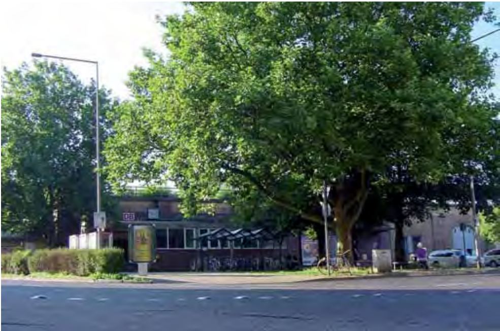
Diese drei Fotos zeigen den Bahnhof vor der Renovierung
