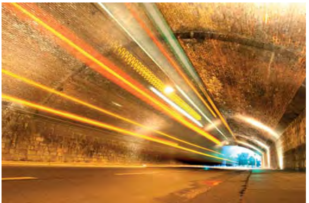
Künstlerische Gestaltung Hütten- straße - Beleuch- tung Unterführung
