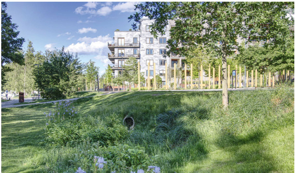
Beispiel für einen lokalen Wasserhaushalt im urbanen Raum: Stockholmer Stadtteil Norra Djurgårdsstaden, Schweden. Foto: Stephan Ellerhorst, Sweco GmbH
